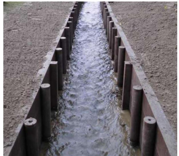
Z. B. als Leiteinrichtung (statisch geprüft) bei Uferbefestigung oder Bachlauf-Sanierung.
