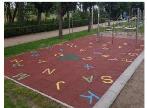
Für den ganzjährigen Außeneinsatz geeignet. Durchgefärbtes Recycling-Gummigranulat, UV- & witterungs- beständig sowie wasserdurchlässig, schnelltrocknend und rutschfest.
